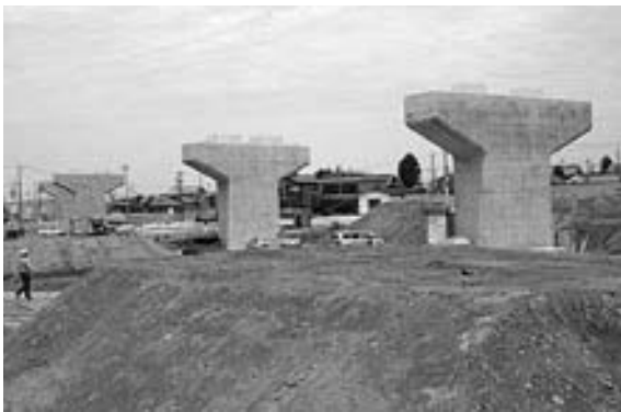
中部縦貫道路松岡インター付近
