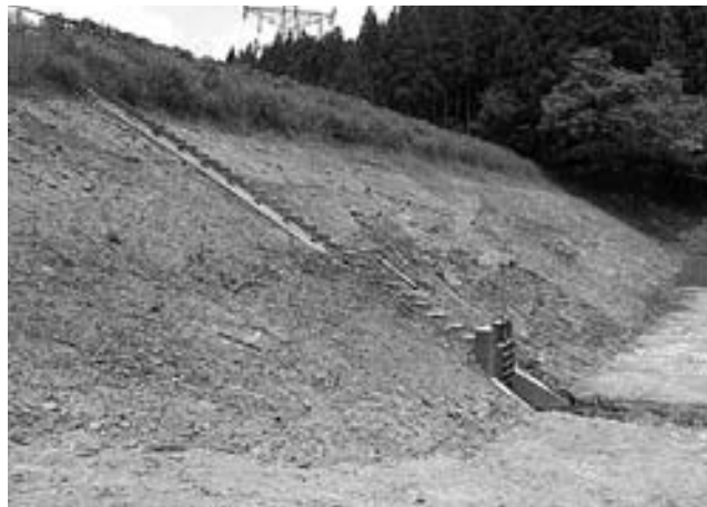
谷口 漏水防止のため水抜きされた溜池
