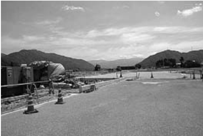
永平寺温泉工事現場
