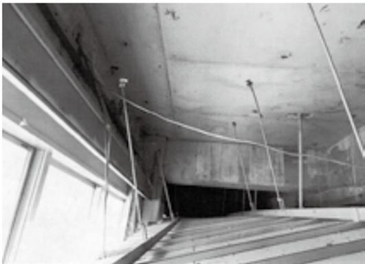
地震で吊ボルトが離れ傾いた松岡東幼稚園の遊戯室天井
